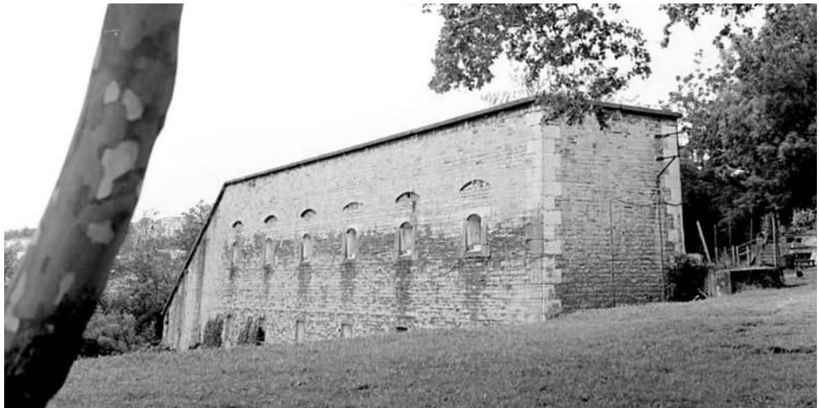
Espace de résidence : Bastion Saint Just (Lyon) vue de l'exterieur
